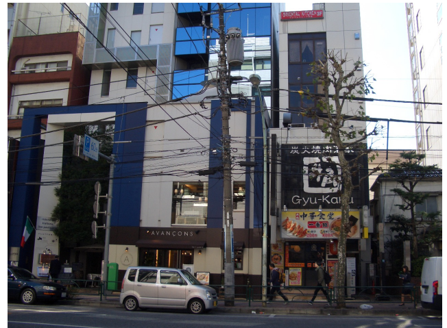
4 緊急輸送道路の対面。電柱が傾いている。
