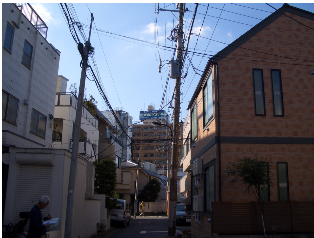
41 幼稚園の間の道路、38の延長。トランス付き電柱が傾いている。電柱の出っ張りは写真36と同様、避難、救助の往来を妨げている。
