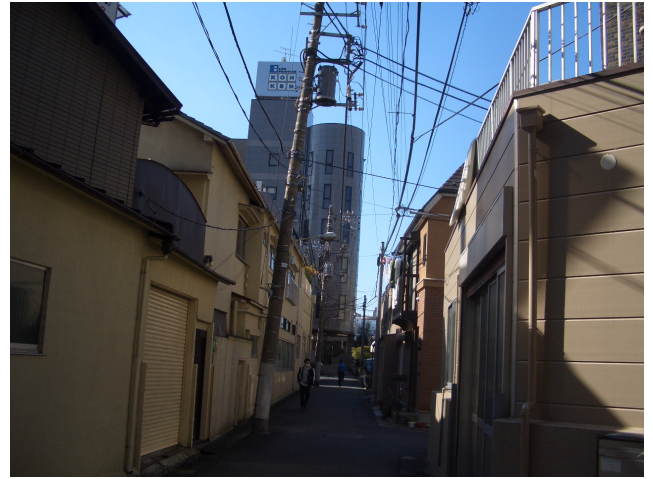
14 電柱の傾き大。トランスは危険を感じる程の大きさではない。
