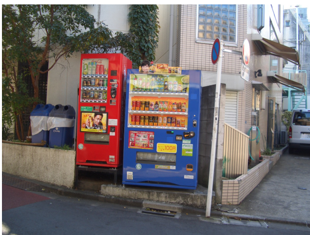
47 自販機、傾倒防止設置。左の段差が有る場合は小鉄骨で架台を製作して安定させて設置。
