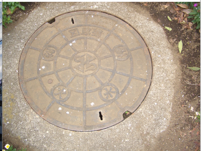
58 松川公園の防火水槽設置マンホール
