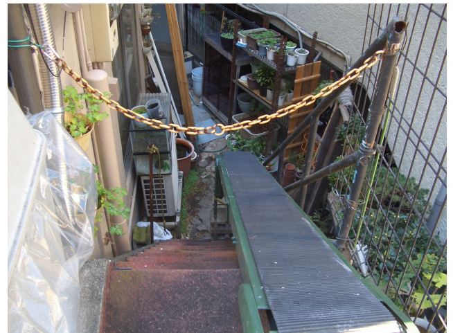
10 私有階段、荷揚げなどに使用。緊急時、奥の住戸からの避難に利用されることもありうる。
