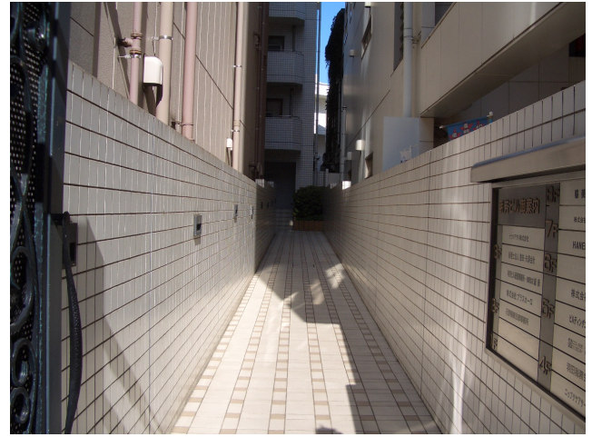
2 マンションからの避難通路。必要巾1.5mは満たしているが広くはない。障害物はなく耐火構造塀。
