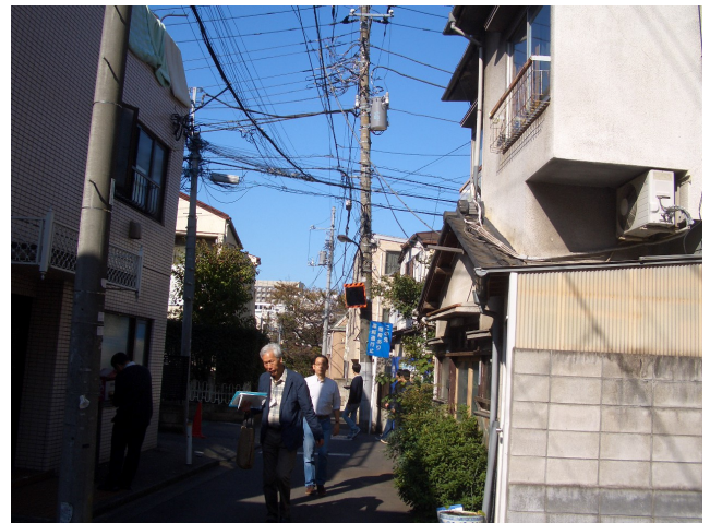
34 電柱の傾倒。配線は複雑なので転倒したら電線等も障害に化する恐れがある。
