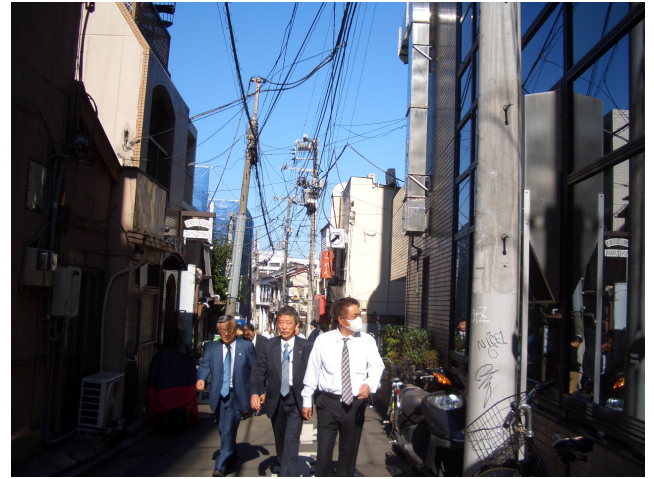
8 トランス付き電柱、傾き大。平時に傾いているのは震災においてはもっと傾く恐れがある。
