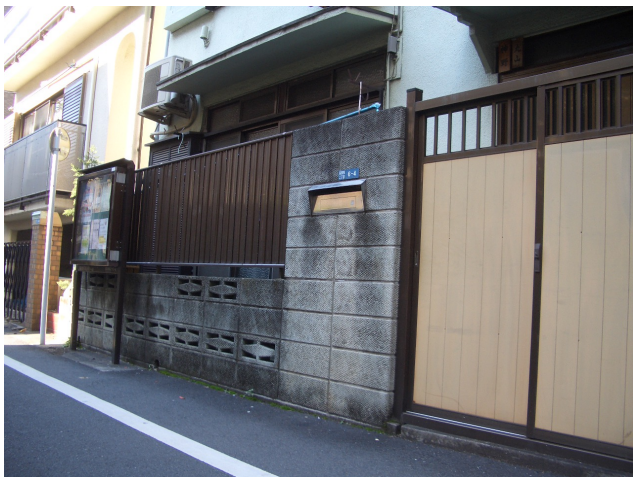
21 道路に面したブロック塀、9段。左のフェンス併用が望ましい。
