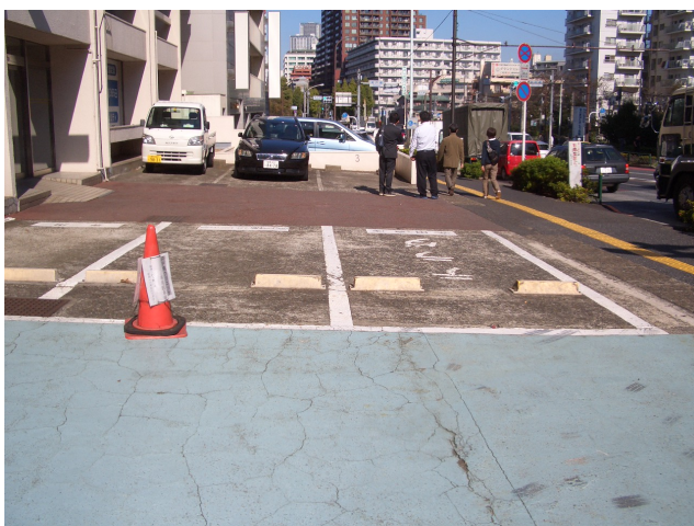
11 車止め。私有地だが囲いが無いので解放されている。しかし車止めにつまづく。
