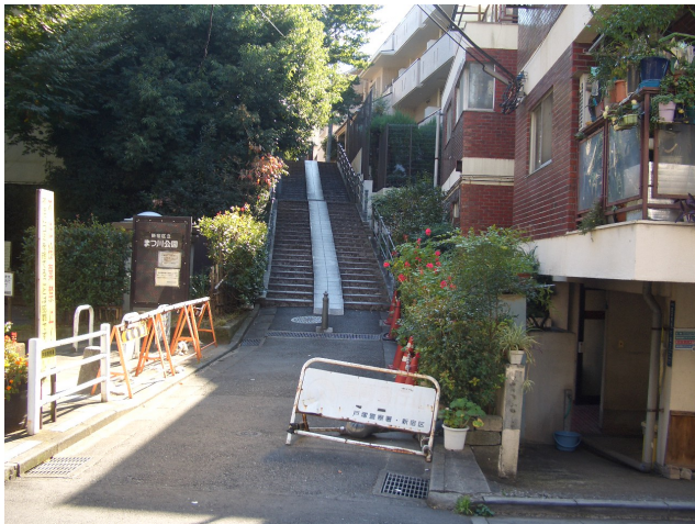
27 坂道。階段はなだらか、手摺も両側に設置している。右側パイプ看板は障害になる。
