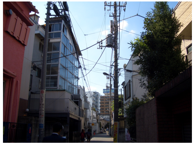
40 幼稚園の間の道路、38の延長。トランス付き電柱が傾いている。
