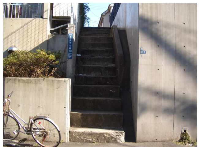
48 写真43、不整形階段。整形する必要がある。
