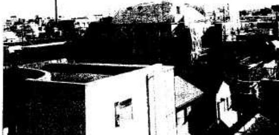
文京区、白山通りから入った閑静な住宅街、このマンションは業者の説明によれば、地下1階、地上6階建てです。屋根の形は斜線制限や日影の規制線ギリギリに作られています。1階は、道路面から1メートルも掘り下げられ、その下に地下室も構えています。
