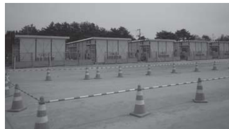
東北被災地初めての仮設住宅(陸前高田市)
